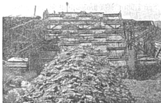
Kuva 12. Lastauskoneilla turpeet siirretään aumoista rautatievaunuihin voimalaitokselle kuljettavaksi.
