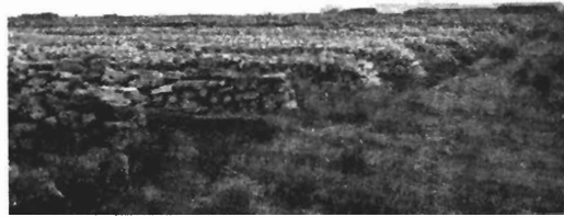
Kuva 1. Turvepehkun kuivausta Länsi-Saksan suurilla nostotyömailla. Taustalla häämöittää n. 20 m korkea ja 200 m pitkä jättiläisauma.
