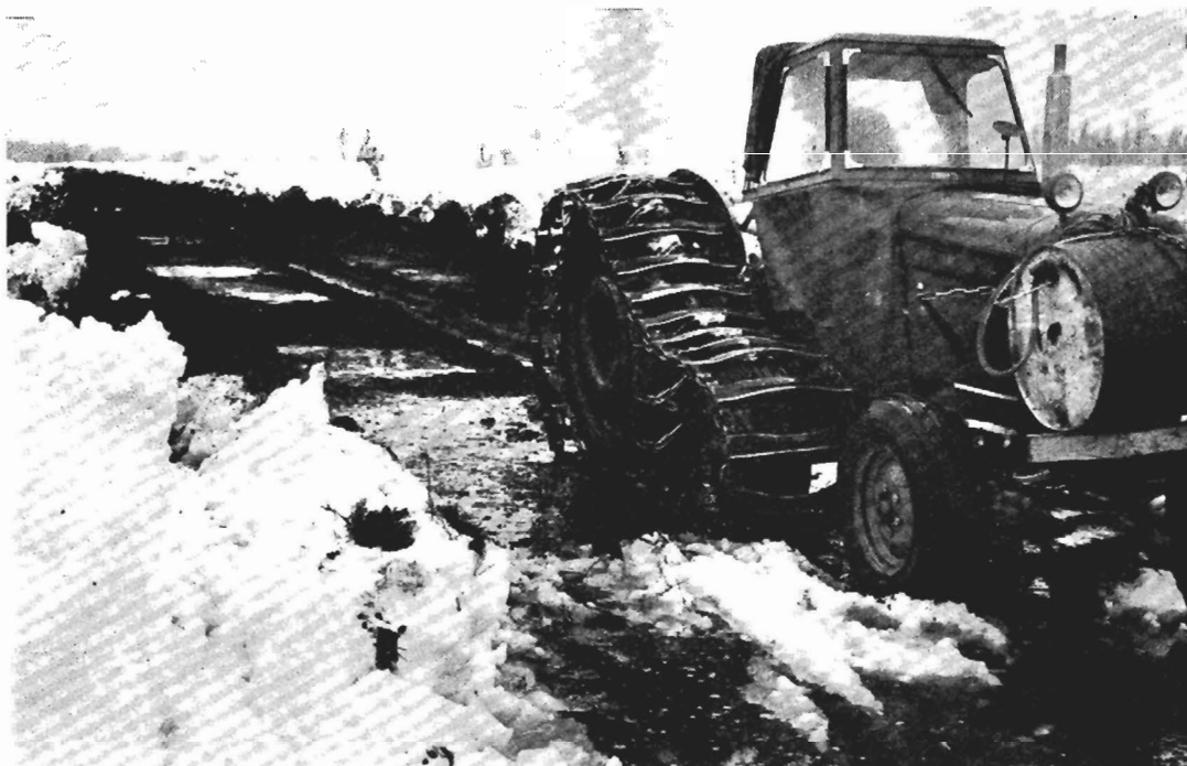
KUVA 5. Esikuivatusnaverointia Lapin maanviljelys-insinööripiirin ojitustyömaalla Muoniossa 1965. Vielä huhtikuussa lumi jouduttiin poistamaan ojalinjalta ennen jyrskyntöä kevyellä puskutraktorilla. Valok. M. Niskanen.
