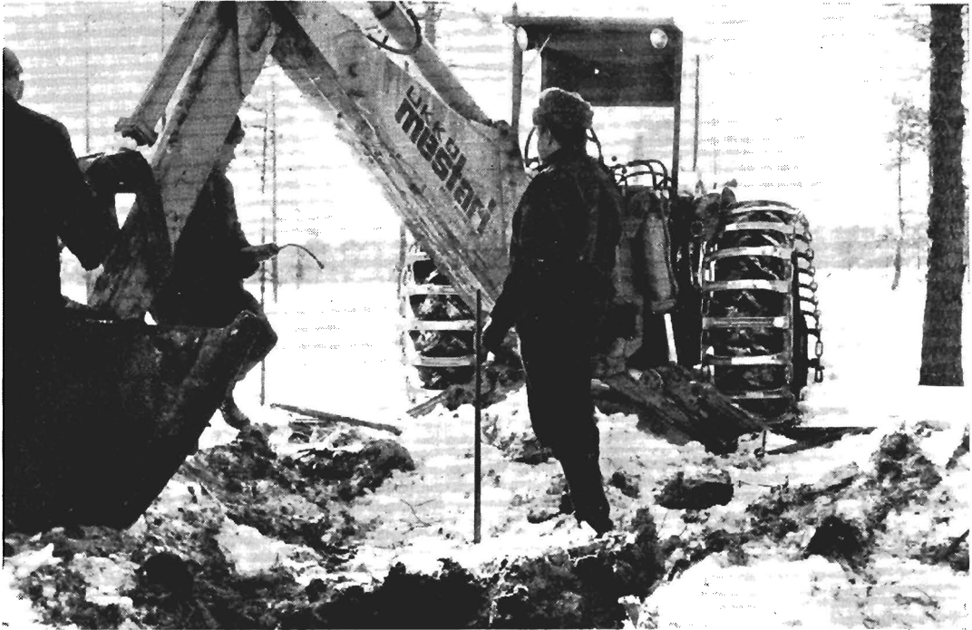
KUVA 3. Puolen metrin vahvuinen routakerros on pakottanut raskaan kaivurin miehistön turvautumaan rautakankeen ja kantopommiin, mikä on hankaluuksista huolimatta parempi keino kuin pakkasen haurastaman kaivulaitteen käyttö hakkuna. Valok. M. Niskanen.
