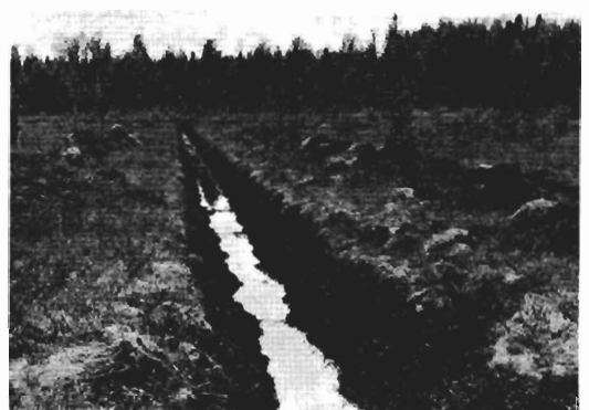
Kuva 8. Kaivurikoeoja samalla nevalta vuoden ku- luttua.
