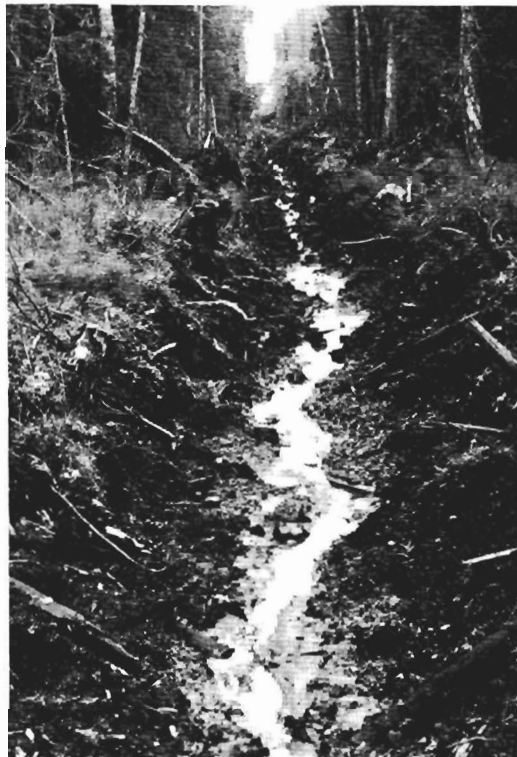
Kuva 6. RhK:n kaivurikoeoja kuukauden kuluttua.
