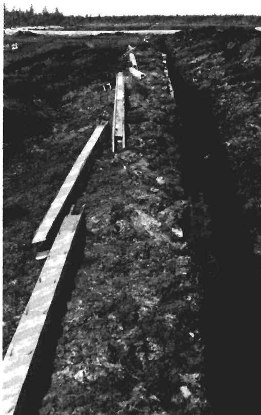
Kuva 8. Lautaputkisalaojan elementtejä. Fig. 8. Elements of board pipe drain.
