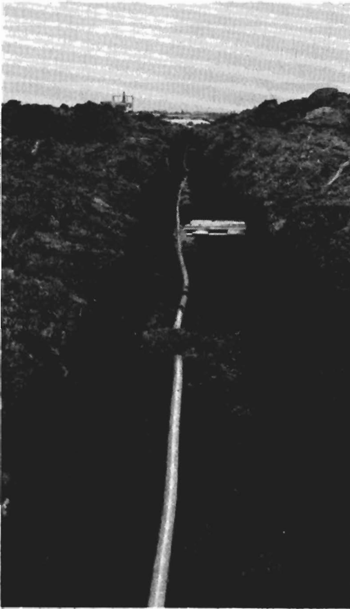
Kuva 9. Muovisalaojaputken ja pohjavesikaivon sijoittaminen kaivantoon.
