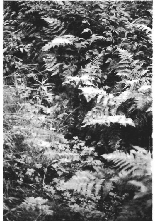
Kuva 5. Saniaiset ovat vallanneet ruoho- ja heinäkorven kaivuriojan luiskat. Kuntoluokka 3.
