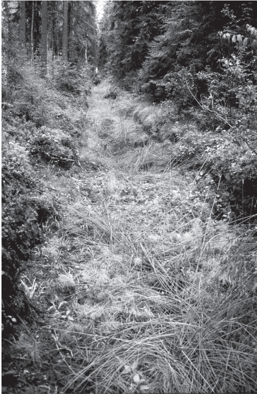
Kuva 1. Hiesusavelle kaivettu laatikkomaiseksi muuttunut sarkaoja 5 vuotta ojituksesta kangaskorvessa Vampulassa. Syynä lähinnä ojaluiskien sortuminen.
